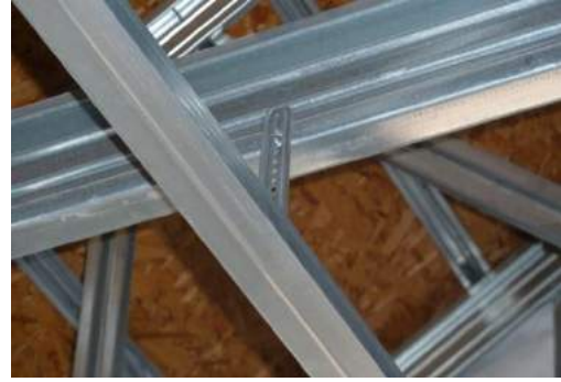
6. מזרוני בידוד יונחו על גבי פרופילי תקרת הגבס לפני הרכבת הלוחות
