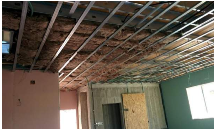
6. מזרוני בידוד יונחו על גבי פרופילי תקרת הגבס לפני הרכבת הלוחות
